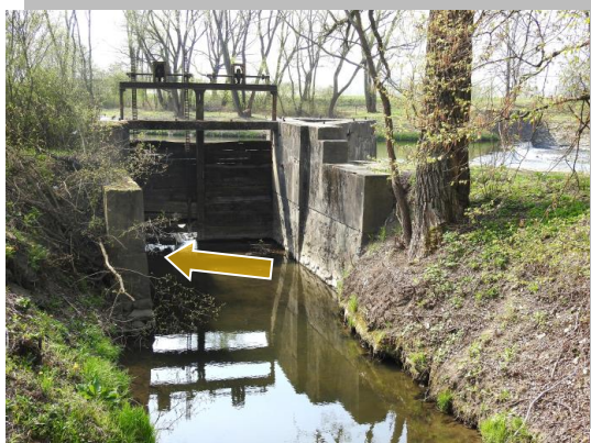
3) Odběrný objekt se stavidlem, v betonové zdi hnízdí konipas horský (viz také obr. 11).
