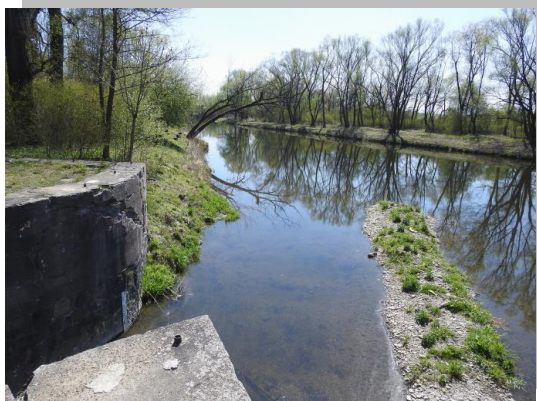
Obr. 7) Nadjezí jezu se šterkovou přepážkou navádějící vodu z řeky do odběrného objektu.
